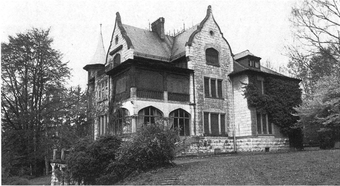
Winterthur. Die von E. Jung und O. Bridler 1900/01 erbaute Kalksteinvilla Lindberg steht inmitten eines herrlichen Parks, die Abbruchbewilligung ist rechtskräftig...
