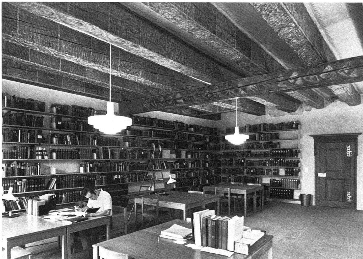
Basel. «Schönes Haus», Nadelberg 6, 1. Stock. Balkendecke 3. Viertel 13. Jh. 1965–1968 restauriert.
