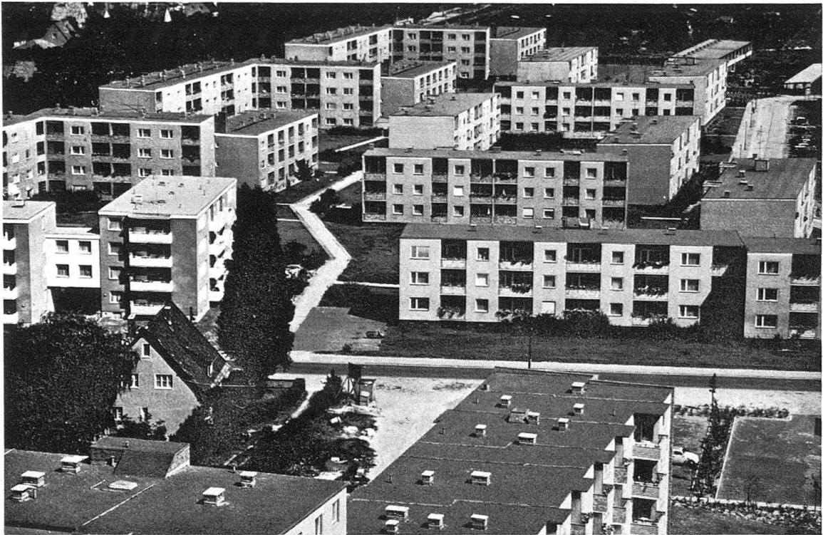
391. Louise-Schroeder-Siedlung I, 1958–61, Aufblick
