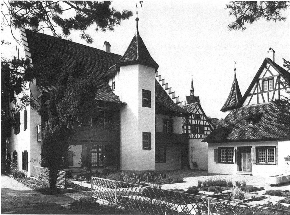
Riehen. Das Wettsteinhaus II, Rückseite; rechts das Wettsteinhaus I. Nach der Restaurierung 1972/73
