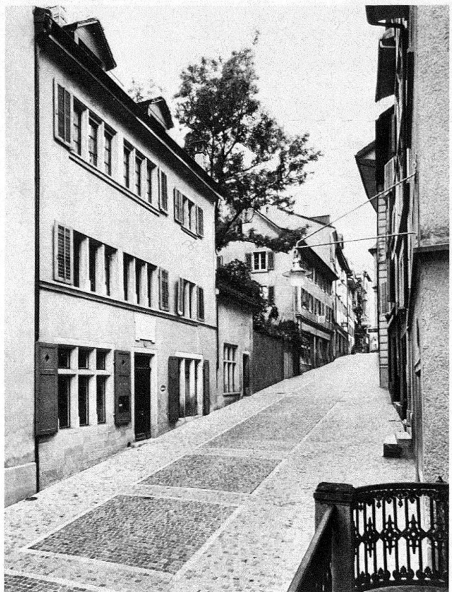
Zürich. Kirchgasse. Die neue Kleinplästerung, ohne Trottoirs – ausgeführt nach Plänen der städtischen Denkmalpflege: ein wohnlicher Bereich, ideal für den Fussgänger
