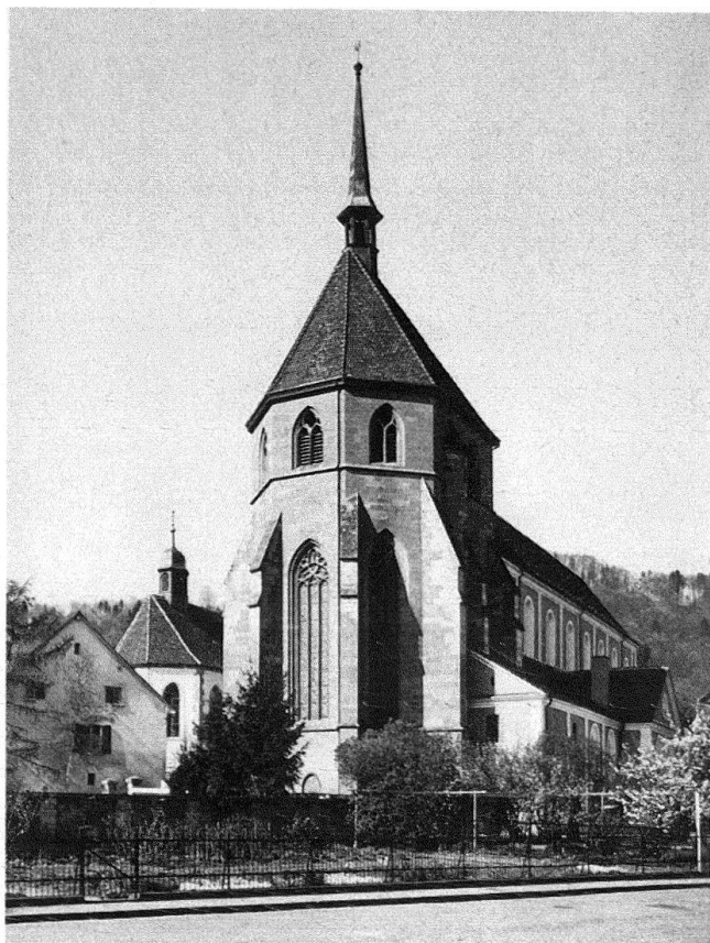
Zurzach. Turmchor der Stiftskirche, errichtet als Memorialbau über dem Grab der hl. Verena, 1294–1347.
