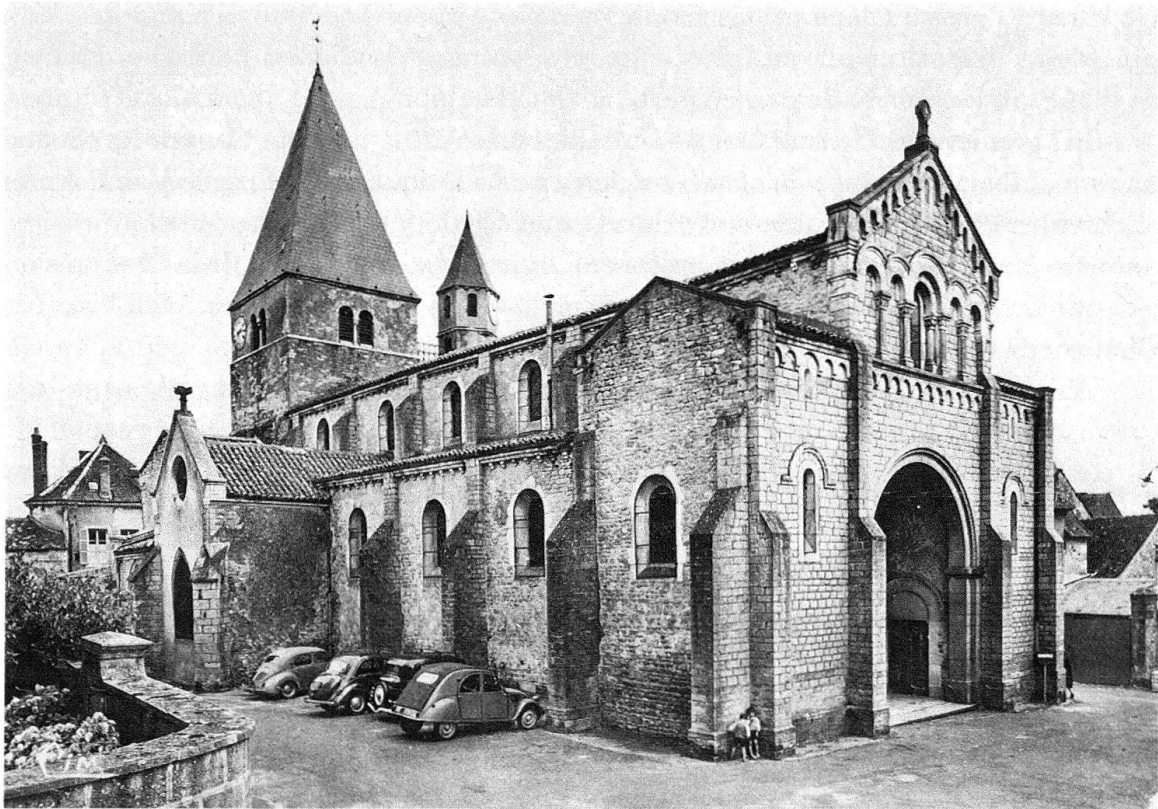
Buxy (Saône-et-Loire). Kirche. Entputztes, mittelalterliches Mauerwerk und eine steingerechte neuromanische Fassade
