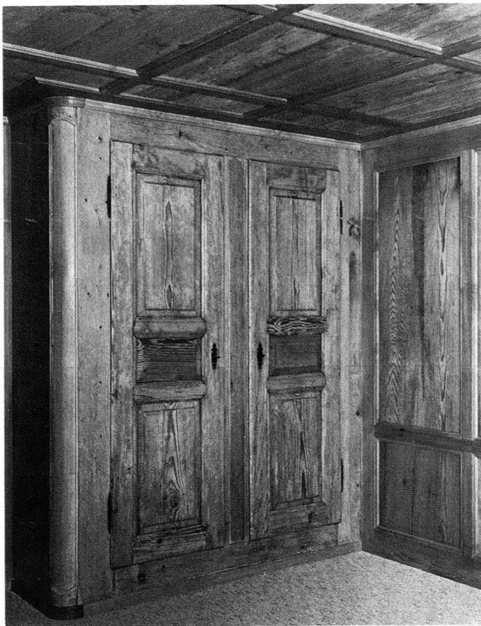
Seeberg, Riedwil. Wohnstube im Mühlestock von 1811. Bei der Erhaltung von Interieurteilen kommt die durch die heutige Werbung verursachte allgemeine Verunsicherung krass zum Ausdruck. Die Wandisolierung bedingt in den meisten Fällen den Verlust aufwendiger Täfer. An ihre Stelle treten Serienprodukte, wie Fastäfer, Putzträger und Kunststofftapeten
