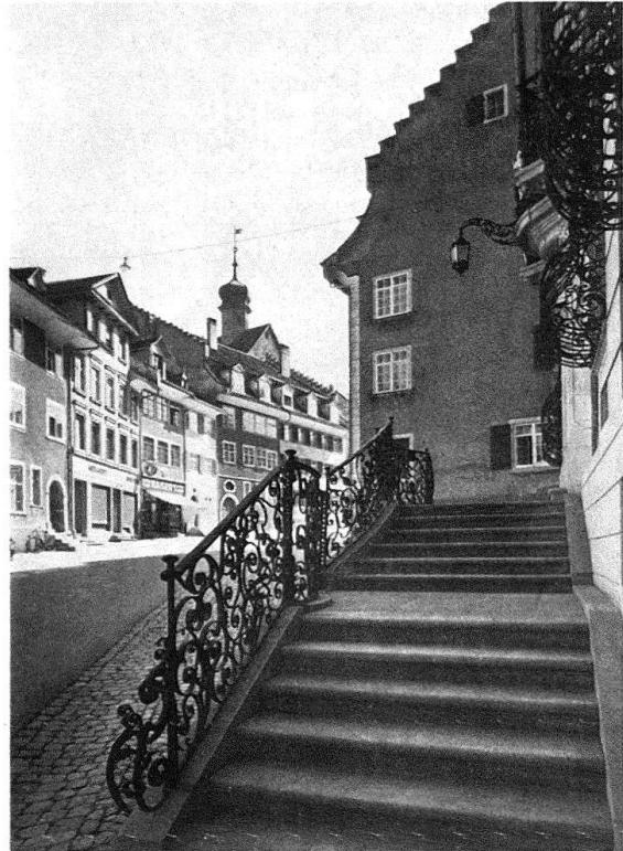
Die zweiläufige Freitreppe mit dem schmiedeisernen Geländer von Isaak Lauchenauer; vor der Restaurierung
