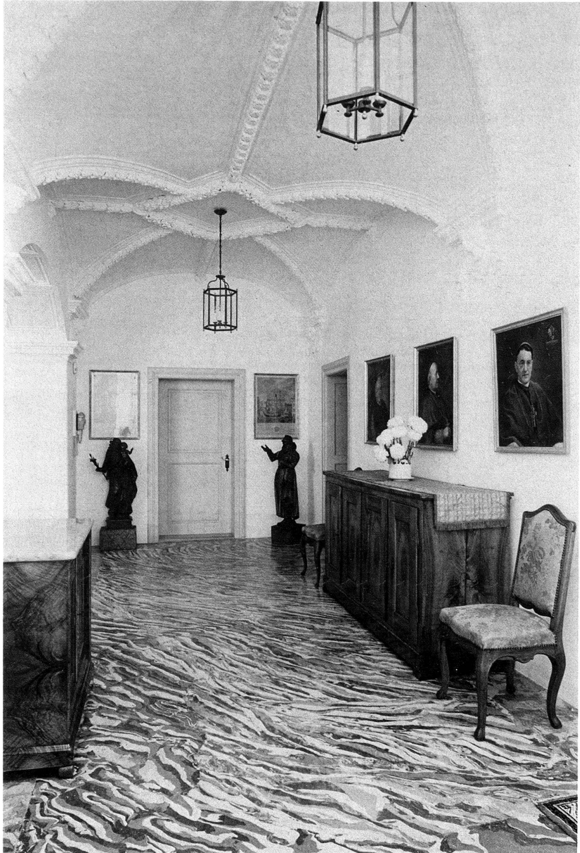
Abb. 5. Gang im 1. Obergeschoss nach der Rest. Fussboden aus geschliffenem Stuckmarmor, datiert 1801
