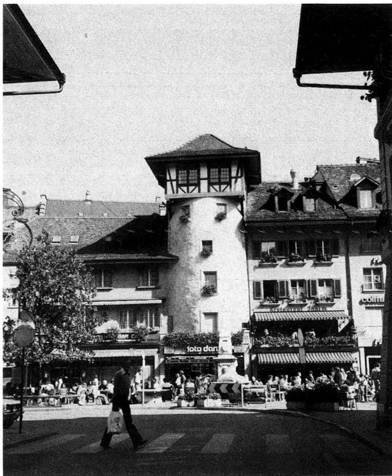
Abb. 5. Holländerturm am Waisenhausplatz. Halbrunder Wehrturm im Verlauf der äusseren Ringmauer des dritten Westgürtels von 1256. Aussen verputzte, massive Turmschale, die Flanken in Sichtquaderwerk. Der Zinnenkranz ist seit dem Umbau zum Wohnhaus im 16. Jahrhundert durch Fenster markiert. Die in Riegkonstruktion aufgesetzte Turmstube des 17. Jahrhunderts diente den ehemaligen Offizieren in holländischen Diensten als Versammlungs- und Rauchsalon, daher der Name
