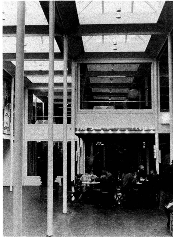
Abb. 6. Kaiser-Häuser: Verglaster Tageslicht-Hof als Zentrum der Passage
