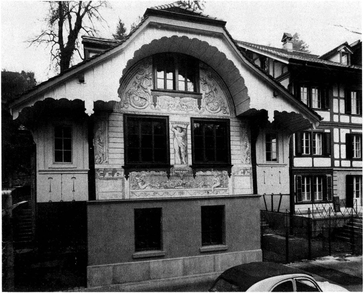
Abb. 2. Bern. Das «Scherz-Haus», Altenbergstrasse 102, nach der Renovation. Rechts im Hintergrund das renovierte Haus 98. Dezember 1981
