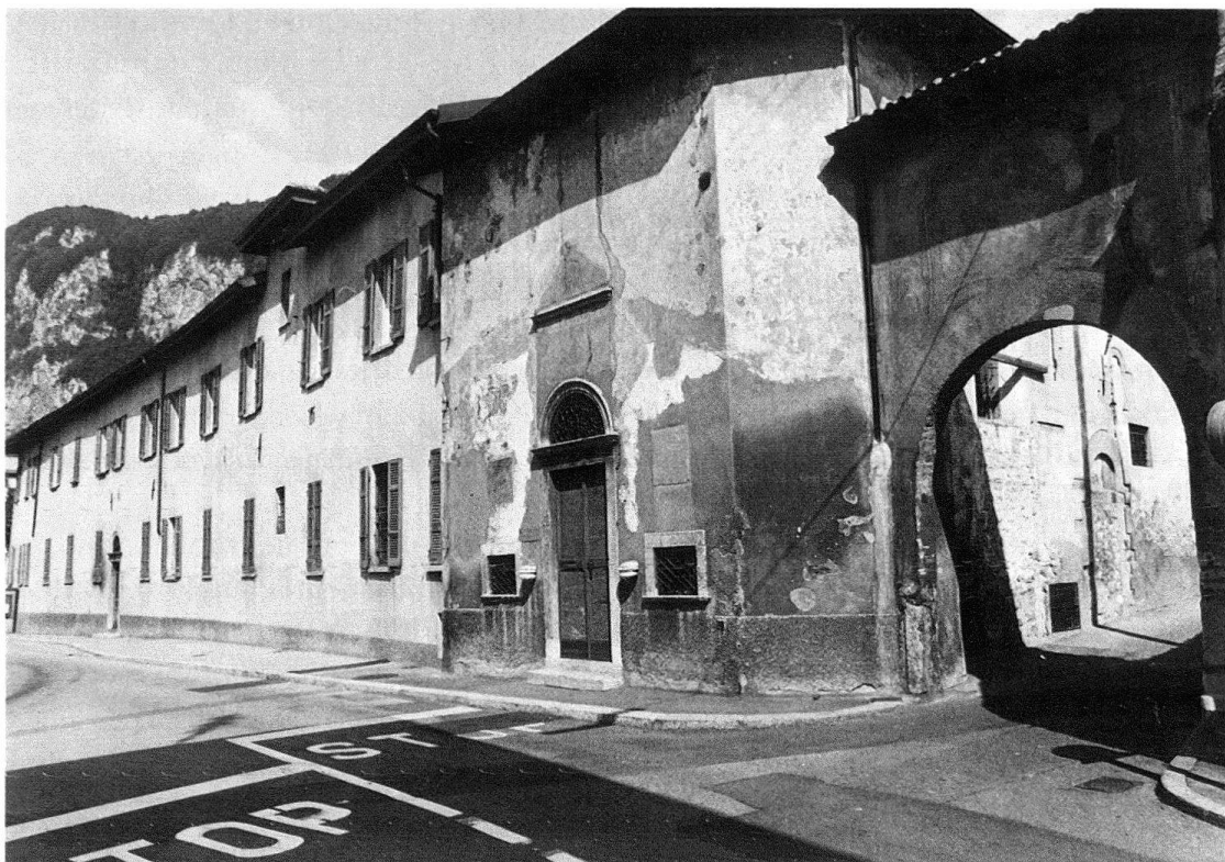
Fig. 1. Mendrisio, antico convento dei Serviti, il complesso visto da sud
