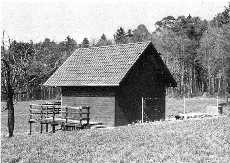
Abb. 6. Wochenendhäuschen in Kilchberg, Forenweid, die- sem ehemaligen Heuhäuschen tat die Umnutzung offensicht- lich nicht gut
