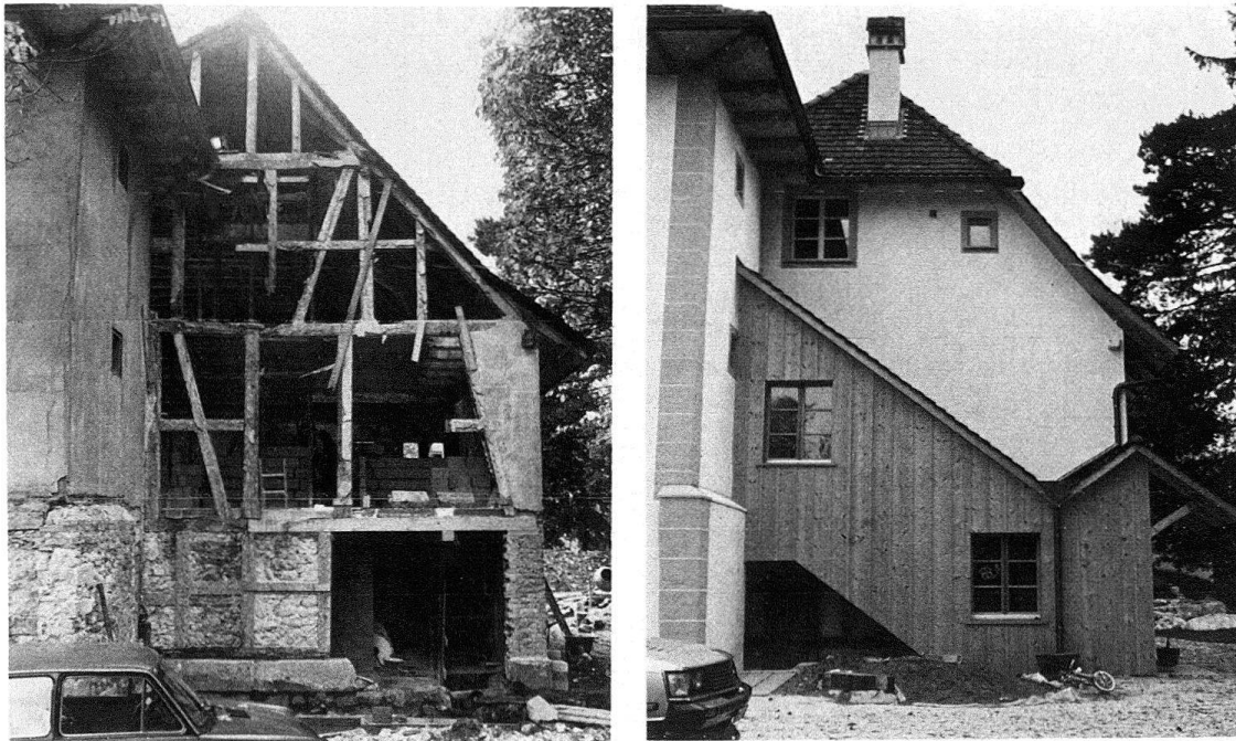
Abb. 4 und 5. Solothurn. Türmlihaus. Ostfassade während und nach der Restaurierung mit einem der beiden neuerstellten, gegengleichen Treppenhäuser
