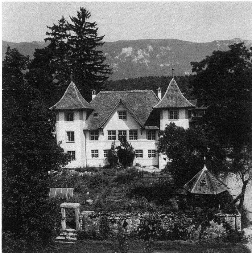
Abb. 3. Solothurn. Das Türmlihaus nach der Restaurierung. Die un- günstige Aufstockung von etwa 1890 ist verschwun- den, der barocke Zier- giebel wieder erstellt. Aufnahme 1982
