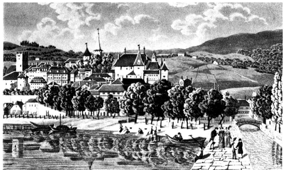
9 Die Schwarze Promenade: La Promenade Noire um 1820 im Südwesten der Stadt mit der «Neuen Brücke» über den Seyonfluss rechts im Bild. Dies alles existiert heute nicht mehr. [Aquarell von F. W. Moritz.]
