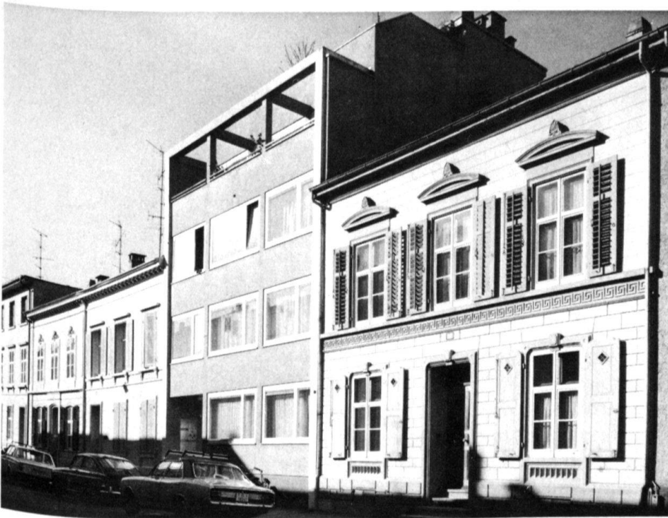
2 Der Spalentorweg ist für die Schonzone vorgesehen. Das Foto zeigt die verheerenden Folgen der Aufzoning von 1939, die nun gestoppt werden, da ein grosser Teil des Ensembles noch erhalten ist (Aufnahme 1974).
