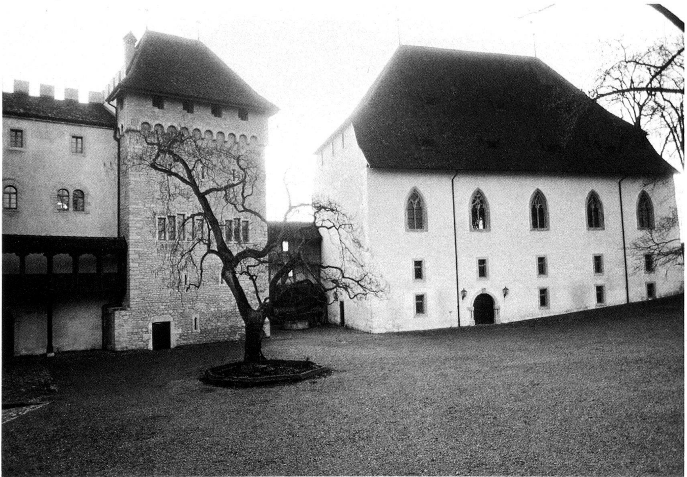
11 Fotografie 1987, Hofansicht Palas, Turm, Ritterhaus (nach der Sanierung 2).
