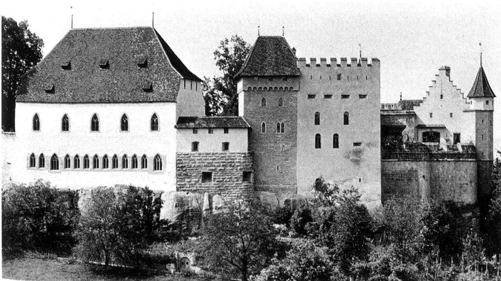
14 Fotografie 1987. Aus- senansicht von Süden: Palas, Turm, Ritterhaus (nach der Sanierung 2).
