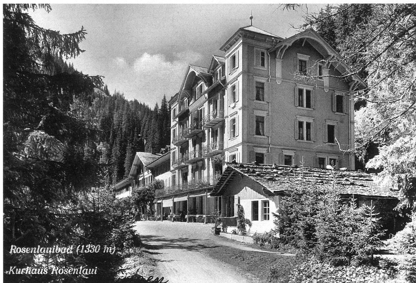
Kurhaus Rosenloui, Historische Aufnahme
