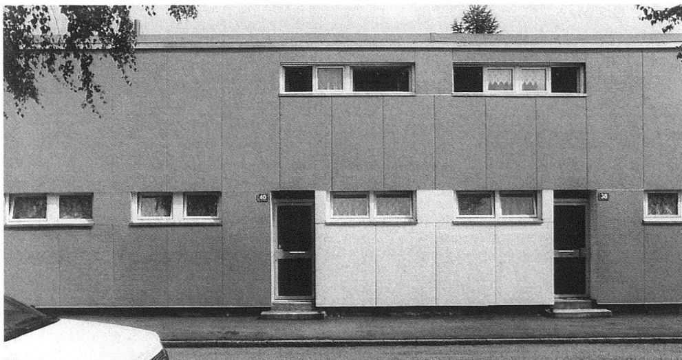
6 Ansicht einer Zeile nach der Fassadenisolation mit olivgrünen und hellgelben Platten, Zustand 1989.
