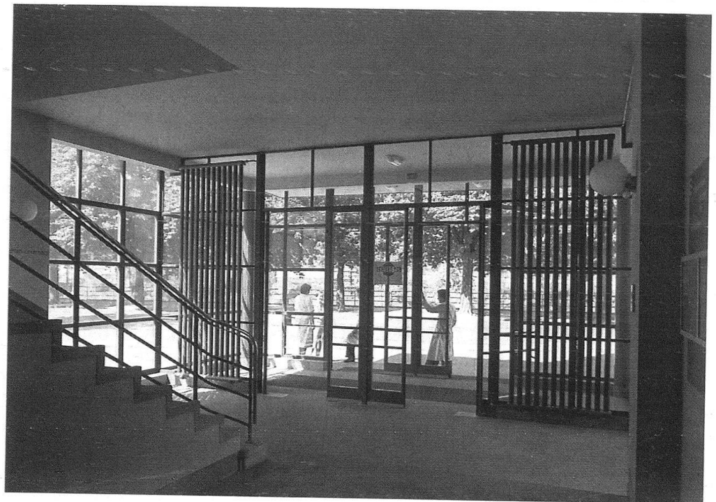
14 Gewerbeschule und Kunstgewerbemuseum Zürich, Eingang Sihlquai. Der Windfang in der fei- nen Detaillierung der dreissiger Jahre.
