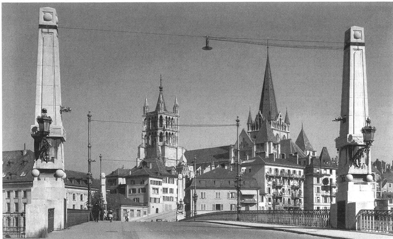
b) Lausanne, östlicher Brückenkopf des Pont Bessières, 1908–1910.
