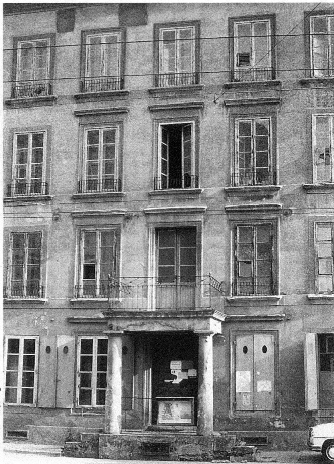
Foto: Denkmalpflege des Kantons Bern
