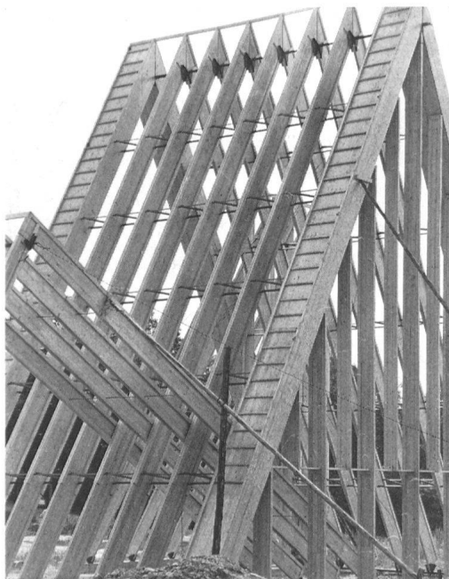
12 Alberto Camenzind, «Weg der Schweiz» während dem Bau. Er besteht aus einem einfachen dreiecksförmigen Balkengerüst.
