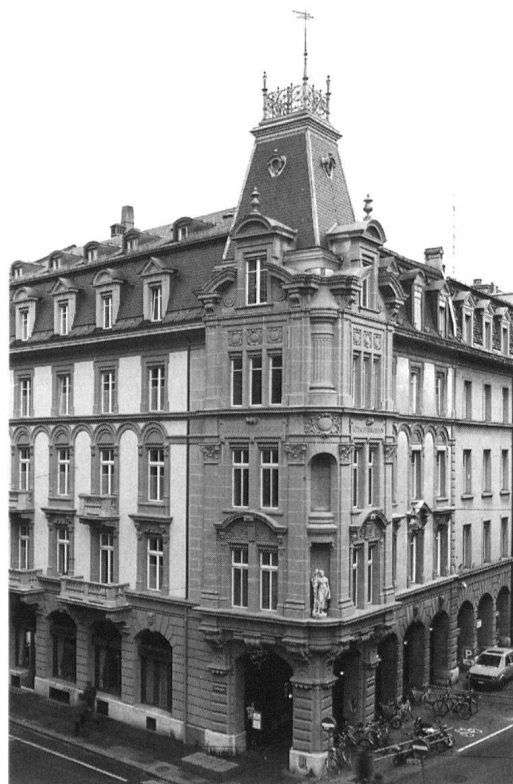
6 Die Fassaden des 1904 von Otto Lutstorferbauten Simplon-Hauses an der Ecke Aarberggasse/Genfergasse wurden jahrzehntelang vernachlässigt. Mitte der siebziger Jahre wurden die Fassaden durch Beseitigung der Dachzier und der Bauplastik verstümmelt. Die 1990–93 durchgeführte Fassadenrenovation hat dem prominenten Eckgebäude seinen Charakter wiedergegeben.
