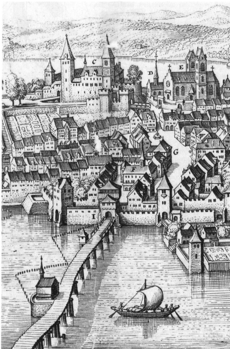
2 Die 1358 erbaute Rapperswiler Seebrücke zählt mit einer Länge von 1850 Schritten zu den längsten Brücken des Mittelalters. Schlangenlinienförmig folgt sie den Untiefen des Seegrundes. – Matthäus Merian (1593–1650), Ansicht von Rapperswil, Ausschnitt, aus: Topographia Helvetiae , 1642.
