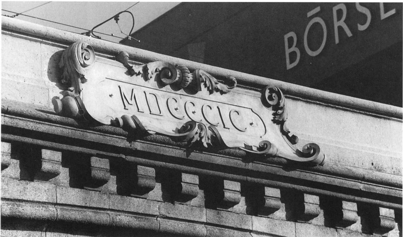
11 Zürich, Stauffacherbrücke. Die neue Jahrzahltafel, Zustand 1992.
