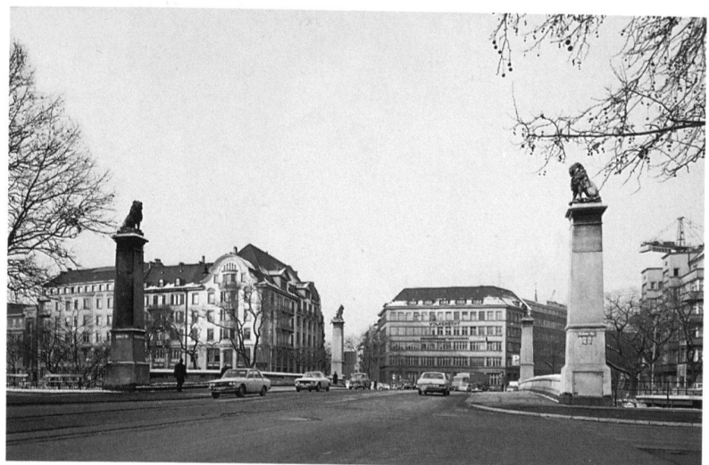
4 Zürich, Stauffacherbrücke. Ansicht von Südosten, Zustand 1980.
