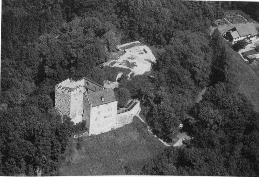
5 Habsburg AG, Westwerk mit Bauten des 13. bis 15. Jahrhunderts.
