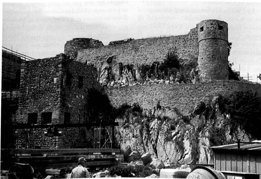
1 Vue prise du côté Sud de l'ensemble de l'Oberschloss avec les fausses-braies; à gauche courtine Ouest. Au sommet vestiges du logis supérieur avec la base de la tour ronde semi-engagée (XIII e siècle). A droite tourelle de guet ouverte à la gorge et courtine de la fausse-braie supérieure. En contrebas, implantées sur l'assise rocheuse, la courtine de la fausse-braie inférieure et la tour carrée ouverte à la gorge qui abrite dans sa partie inférieure une citerne (XIV e siècle avec modifications du XVI e siècle). A remarquer la hauteur limitée des courtines des fausses-braies et l'implantation de végétation sur le couronnement de ces deux murs (juillet 1995).
