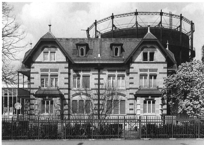
Schlieren, Gaswerk, 1900 nach Plänen von Stadtbaumeister Arnold Geiser erstelltes Angestelltenhaus für zwei Familien, Südfassade. Im Hintergrund Teleskopgasbehälter aus der Gründungszeit, Inhalt 25 000 m³, Höhe 34,5 m, Durchmesser 36,4 – 38,6 m.
