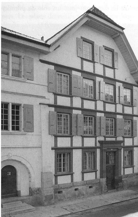
3 Moudon, maison Bize, rue Grenade n° 32, construite en 1696 par le vidome Loys de Villardin pour son lieutenant au vidomat, avec annexe sud de la maison de Villardin. – A la subordination sociale correspond une subordination architecturale. Au portail, les colonnes sont remplacées par des pilastres.
