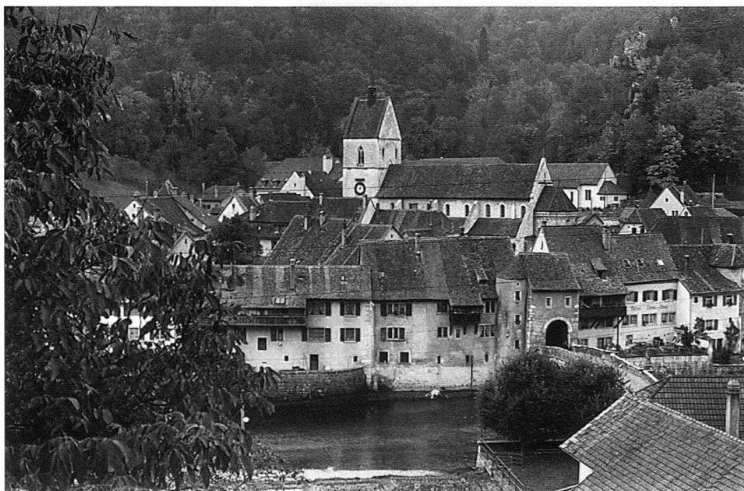
2. St. Ursanne (JU): Mit dem Talererlös 1979 wurde die Stiftung Pro St-Ursanne gegründet. Sie leistet bis heute gezielt Beiträge an Restaurierungsarbeiten Privater in der Alistadt. Aufnahme 1979.
