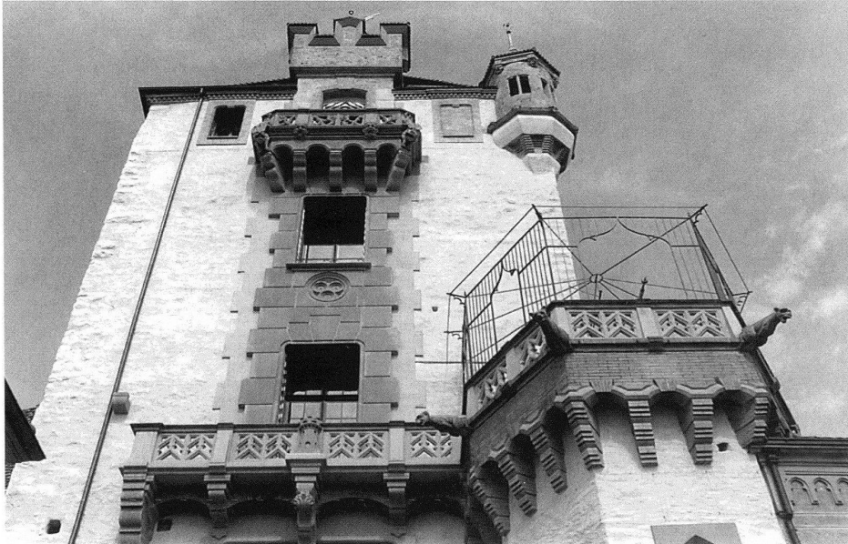
7 Oberhofen, Schloss, Bergfried mit Terrasse über Kapellentürmchen. – Das die Terrasse umschliessende Gitter auf dem Dach des Kapellentürmchens war als Träger für Kletterpflanzen gedacht und zeigt Merkmale der historistischen Stilvielfalt.
