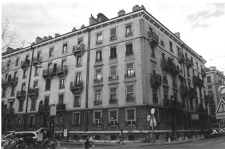
Genève, ensemble de 11 immeubles d'habitation, rue Gourgas 10-12-14-16 / ch. Humbert 1-2-4 / rue des Bains 36-38 / rue de la Muse 7-9, 1897 (autor.), Marc Camoletti, architecte. (A. Gueissaz)
