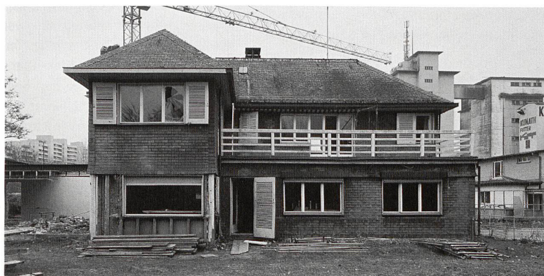
Das Saffa-Haus von Lux Guyer vor seiner Demontage in Aarau, bereits halb in den Originalzustand zurückgeführt. (Repro, S. 64; Hannes Henz)
