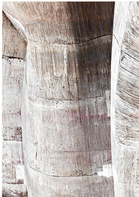
Betonplastik: Schalungsbild am Goetheanum
