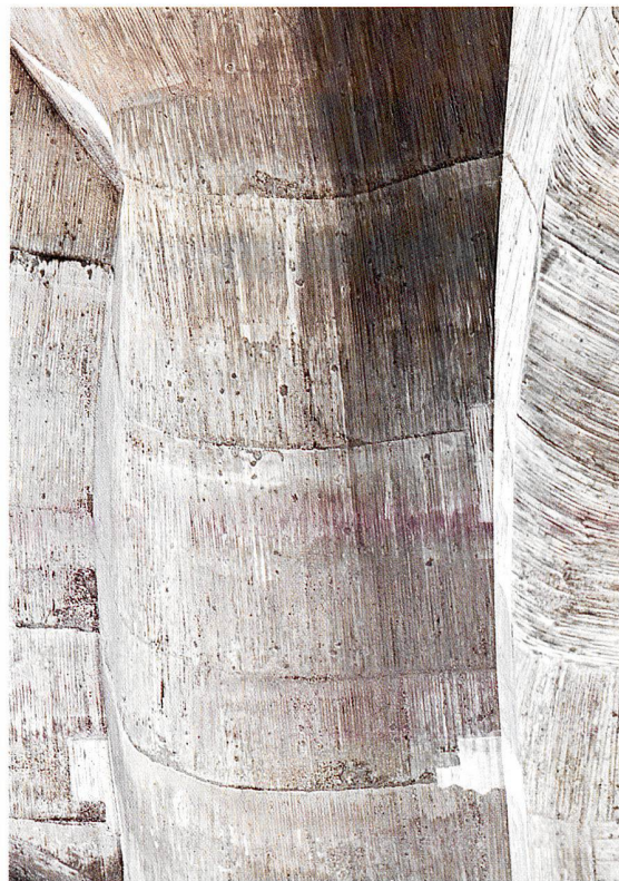
Betonplastik: Schalungsbild am Goetheanum
