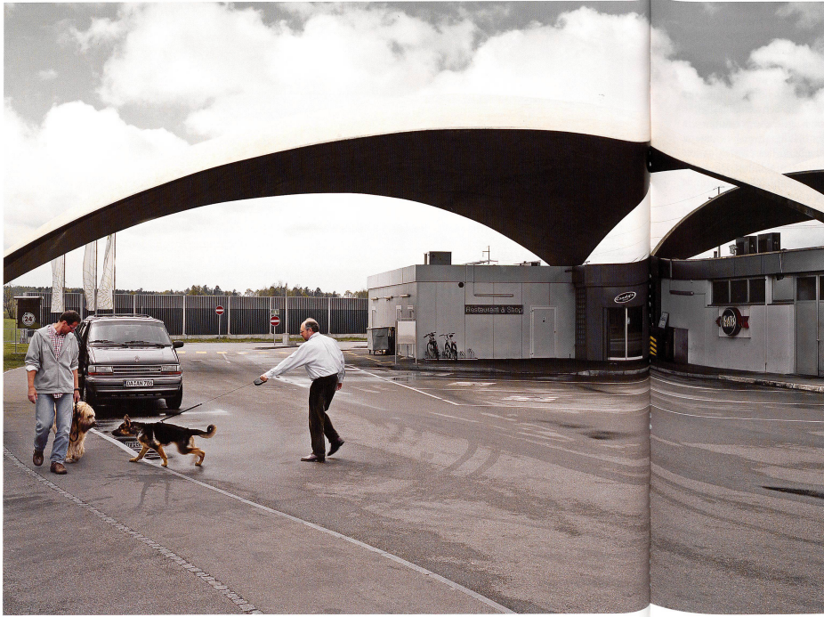
Islar-Schalen: 15 cm dicke Stahlbetonschalen in Dettingen-Süd, erbaut 1988 (aus der Serie «Menschen vor Ort» von Valentin Jock)
