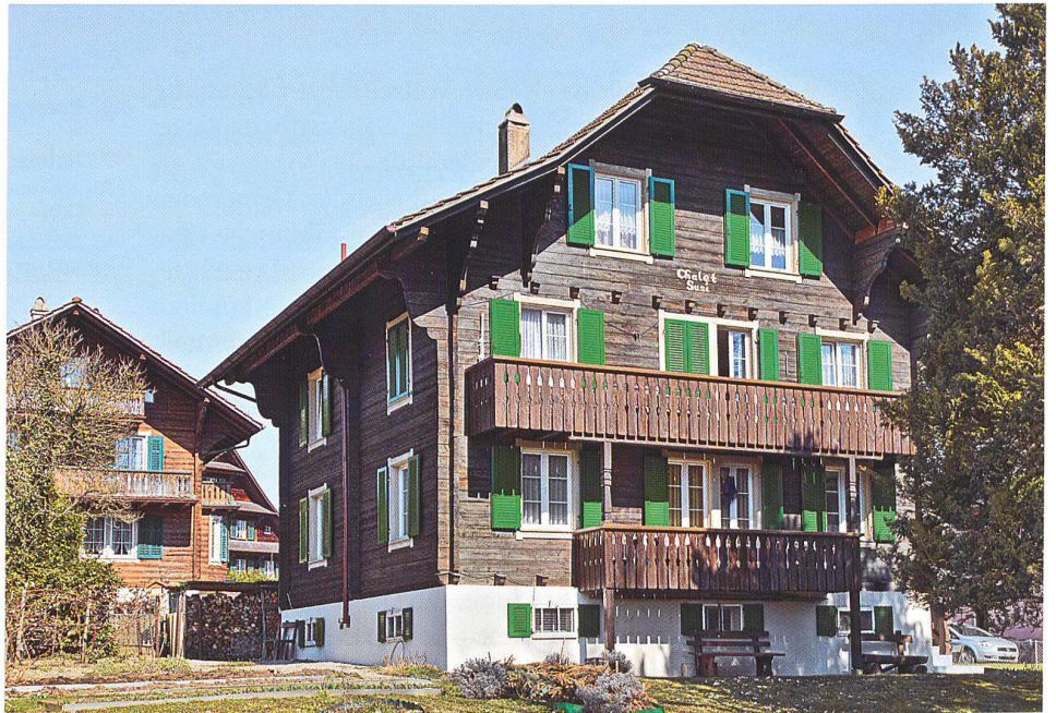
Chalet Susi in Cham: Erbaut 1929 von Baumeister G. Muggli für Simon Wigger, Papierfabrikarbeiter. Blockbau mit Teilwalm, grosse Pfettenkonsolen, Rankenfriese beim Hauseingang
