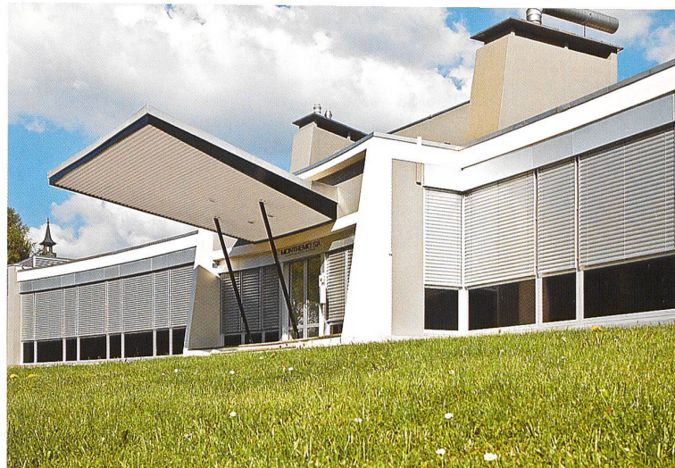
La Chaux-de-Fonds, Rue des Electricques 38. Usine. 1957–1958, par Tell Jacot et Roland Studer. Rompant avec la typologie industrielle locale de la barre étroite, le bâtiment exprime par sa marquise en projection, non sans emphase pour un si petit volume, la vitalité de l'horlogerie à cette époque. Le plan distribue clairement les gens et les fonctions.
