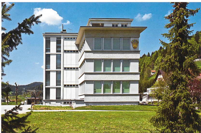
Le Locle, Rue de France 61. Usine Rolex construite en 1967 par P.-A. Davoine architecte. Trois niveaux de bureaux et d'ateliers. Fondé sur pieux, le bâtiment présente une structure entièrement en béton armé qui libère les espaces de la retombée des charges. Exception faite du corps des sanitaires et de l'escalier hors-œuvre au sud, le bâtiment s'inscrit dans la typologie industrielle locale.
