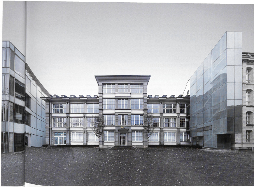
IWC-Stammhaus von Johann Gottfried Meyer (1875 erbaut), von funktionalen und innovativen Neubauten umgeben
