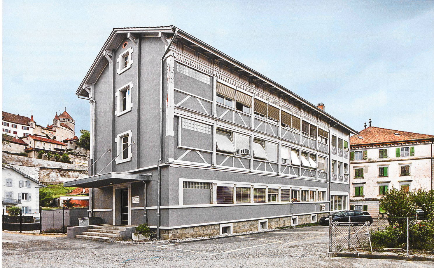
La fabrique principale, de 1886–1887, vue du sud-ouest, état actuel. A droite, l'ancienne foule reconstruite en 1890 et transformée encore en 1908 à l'étage supérieur
