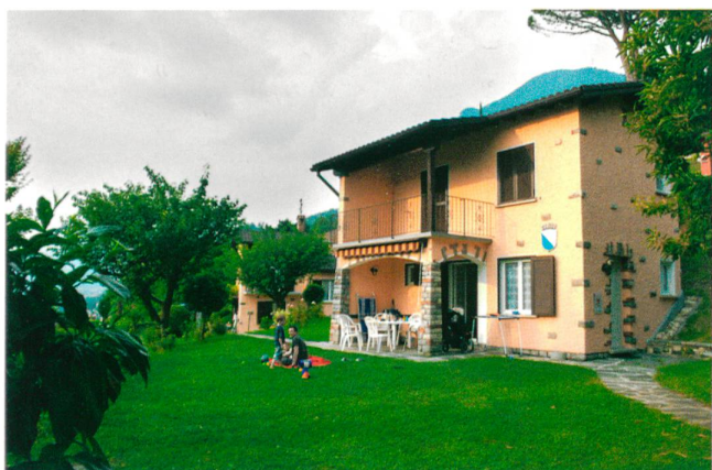
Haus «Zürich» in der Reka-Feriensiedlung Albonago. Foto Reka
