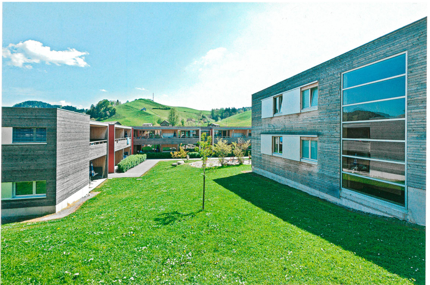
Reka-Feriendorf in Urnäsch im Appenzellerland am Fusse des Säntismassivs, Architekt Roland Gnaiger. Foto's Michael Peuckert
