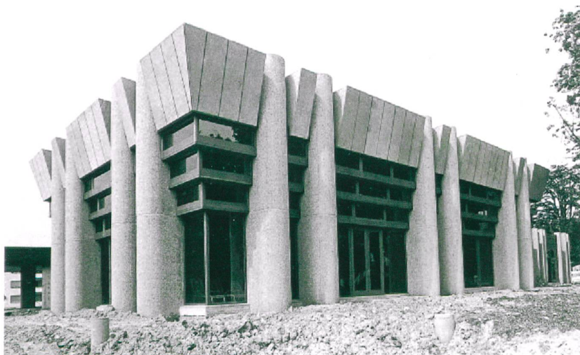
1977 Le Centre thermal construit selon les plans de l'architecte François Cattin et inauguré le 10 septembre 1977 à l'occasion de la renaissance des activités thermales à Yverdon-les-Bains après une interruption de dix-huit ans. (Photo Alain Martin, 1977)
