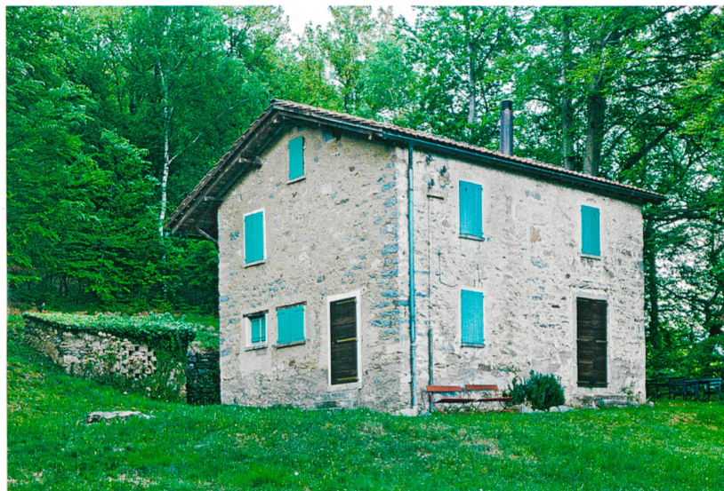
Monti di Roveredo, Casa Eli Conti, spätes 19. Jahrhundert. Das Haus gehört zu den ältesten Ferienhäusern in der Region. Der heutige Zustand geht auf eine kurz vor 1909 erfolgte Verdoppelung des einfachen Turmhaus-Grundrisses zurück. Foto Michael Peuckert
