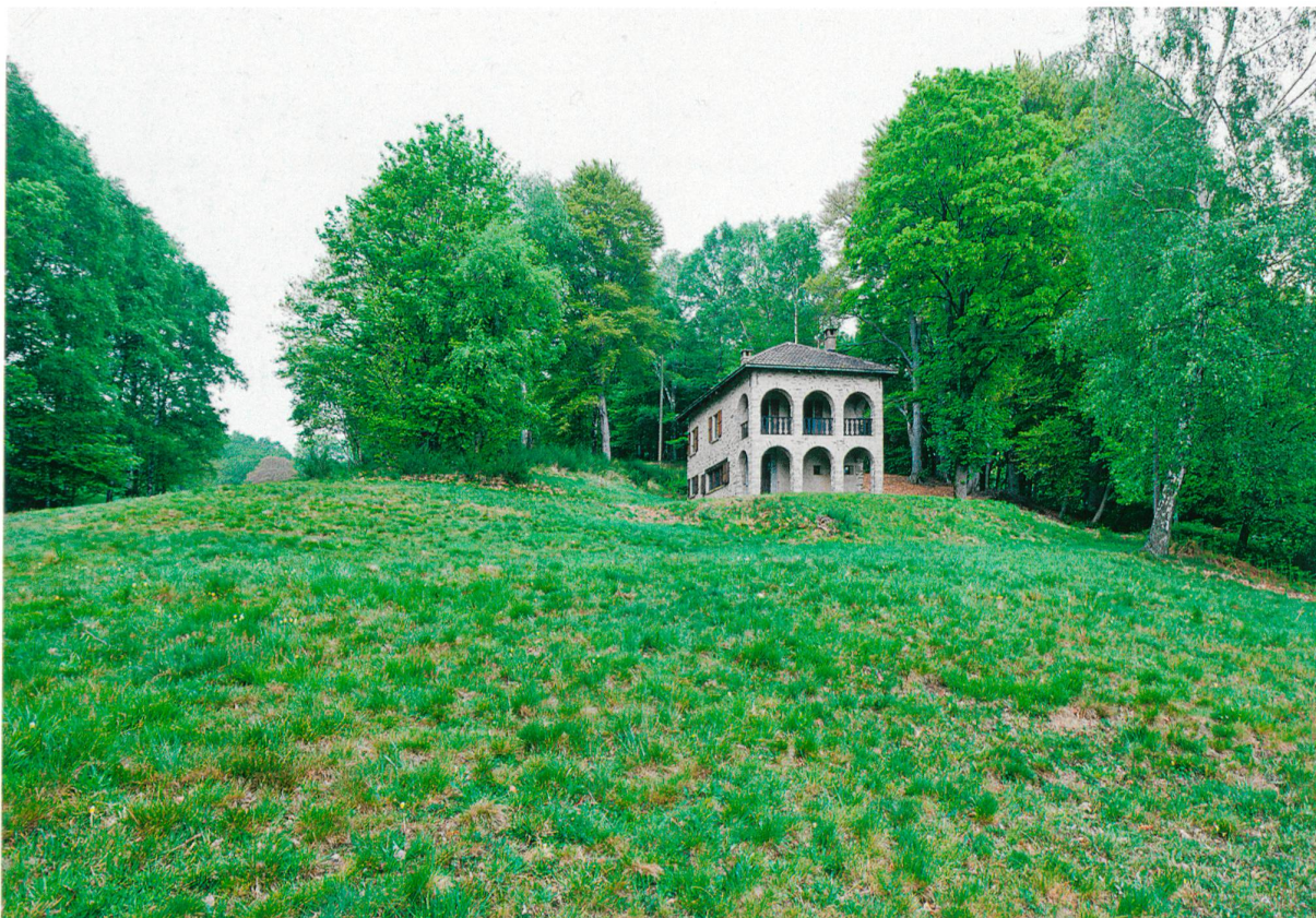
Monti di Bigorio, Casa P.A.M., 1932. Architekt: Mario Chiattono. Mit dem für sich und seine Geschwister erbauten Ferienhaus verband Chiattono auf originelle Weise rationale, neoklassizistische und am Heimatstil orientierte Bauformen. Foto Michael Peuckert
