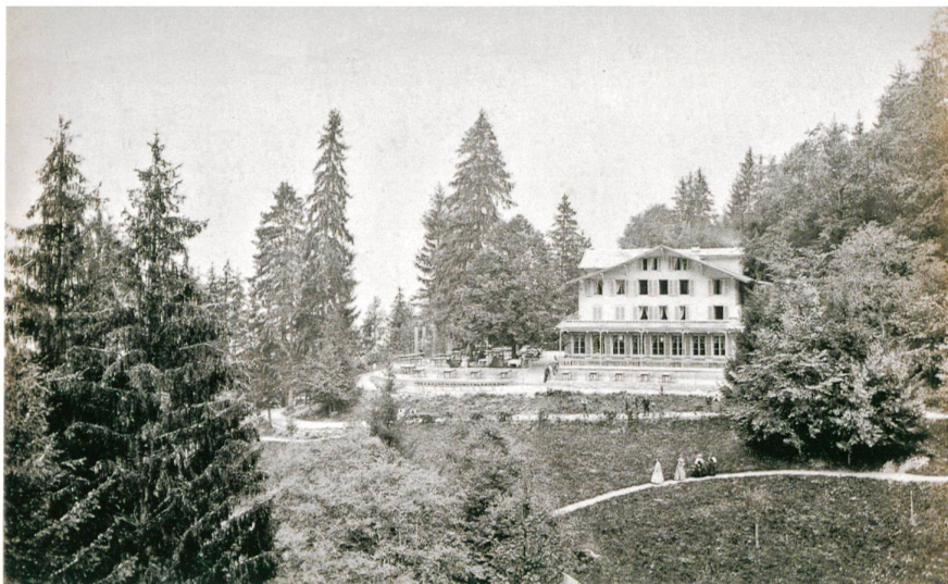
Abb. 8 Fotografie des 1858/59 unter der Führung von Eduard Schmidlin erbauten «hôtel supplémentaire». (Archiv Hotel Giessbach)
