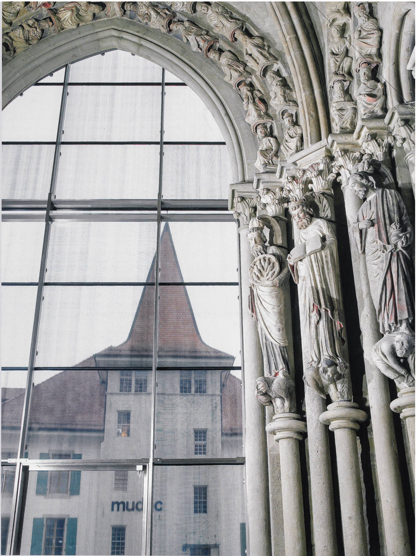
Vue intérieure du portail peint avec les nouvelles verrières de fermeture (photographie Rémy Gindroz, La Croix-sur-Lutry, 2008)
