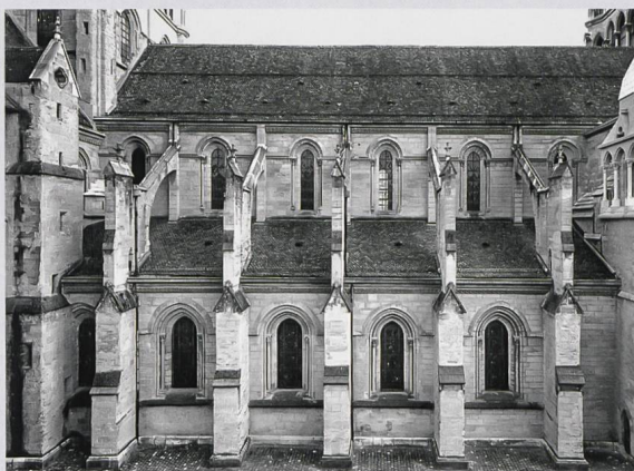
Façade nord de la nef, vue générale avant les récents travaux de conservation (photographie Claude Bornand, Lausanne, 2000)
