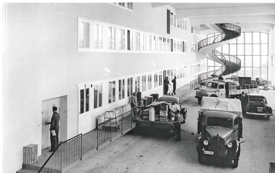
Il piazzale ricavato sotto il corpo principale dell'edificio consente il carico e scarico delle merci (Archiv ABB Schweiz, Baden)
