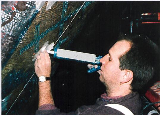
Injizieren von flüssigem Mörtel
