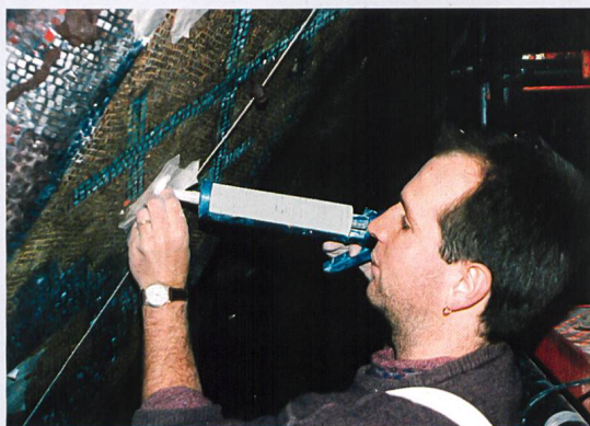
Injizieren von flüssigem Mörtel
