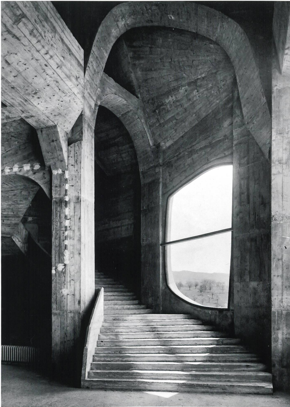
Abb. 9 Lothar Jeck, Innenansicht des West- treppenhauses des Zwei- ten Goetheanums
